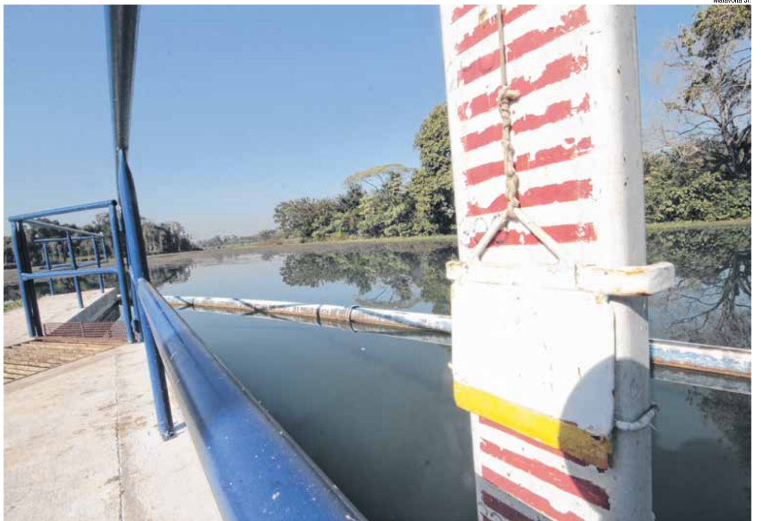
Volume de água do Rio Batalha na região da lagoa de captação está na marca dos 3 metros de altura, considerado ideal para não prejudicar o abastecimento da cidade
